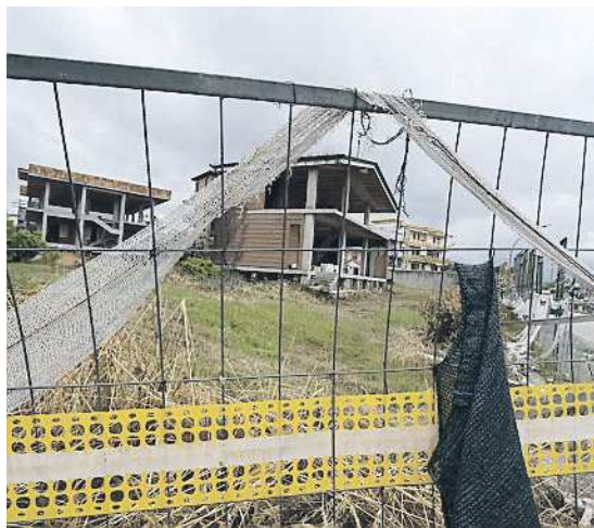
I TEMI Qui sopra uno dei tanti cantieri sotto sequestro, in alto il traffico impazzito: Pomigliano è la città più inquinata d'Italia newfotosud, renato esposito
